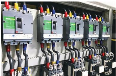
断路器是电力配电系统中的一个关键组件, 它负责保护电气系统免受过载、短路和其他故障的损害而中断工作。断路器必须进行的关键测试是瞬时脱扣试验, 该测试旨在验证断路器在故障条件下会瞬间跳闸。换句话说, 当断路器检测到电气系统中的故障时, 它应该在几分之一秒内打开。
